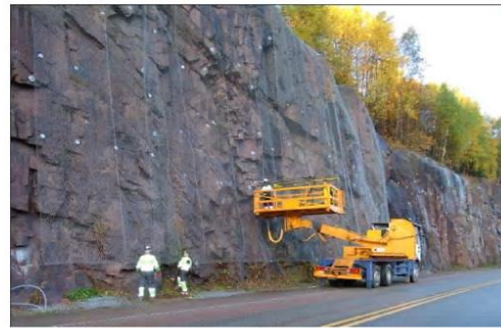
चित्र 9.7 सुरंग व सड़क निर्माण में बोल्टिंग द्वारा दीवार का स्थिरीकरण
