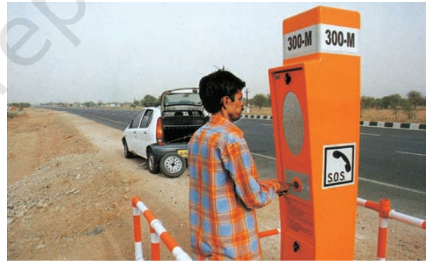
चित्र 7.10 – राष्ट्रीय राजमार्ग-8 पर एक आपातकालीन कॉल बॉक्स
